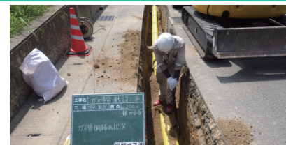
▲ ガス管を道路に設置する工事の様子
